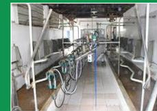
Utilizar detergente alcalino após as ordenhas para remoção de resíduos orgânicos e detergente ácido, uma vez na semana, para remoção de resíduos minerais da tubulação.
